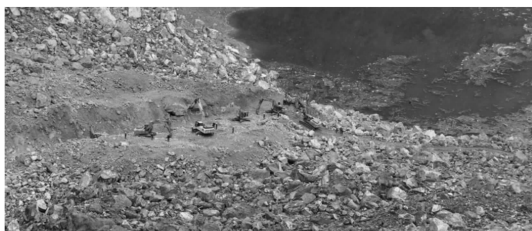
图3 多机接力开挖转运
