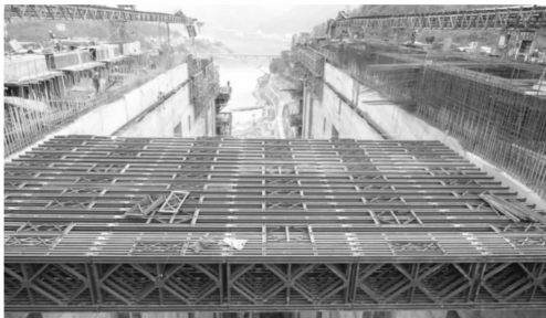
图 1 贝雷梁安装形象图
